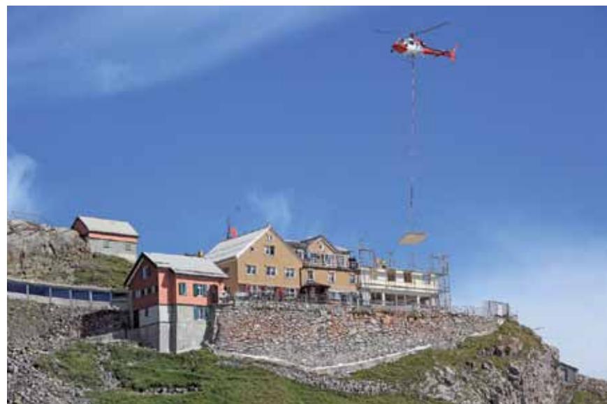
Ein Helikopter bringt die Elemente für das Berggasthaus «Alter Säntis».
