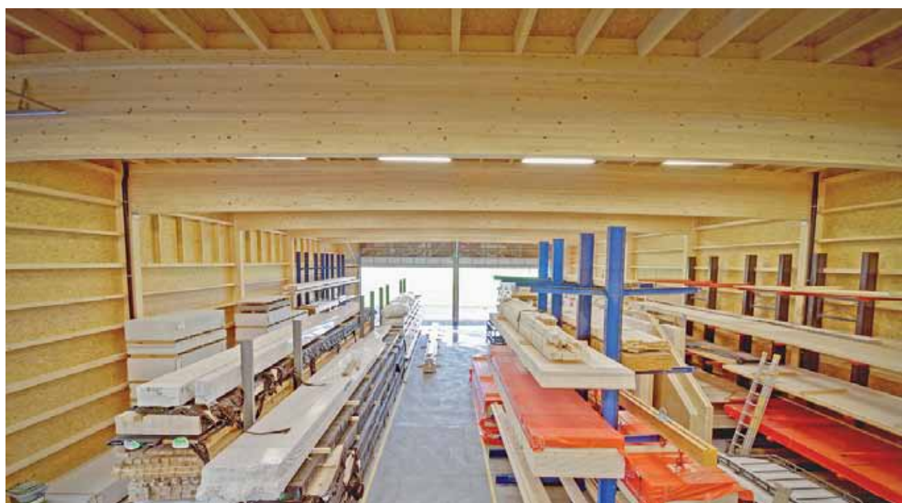
In der neuen Lagerhalle können die Baustoffe und fertigen Elemente optimal gelagert werden.
